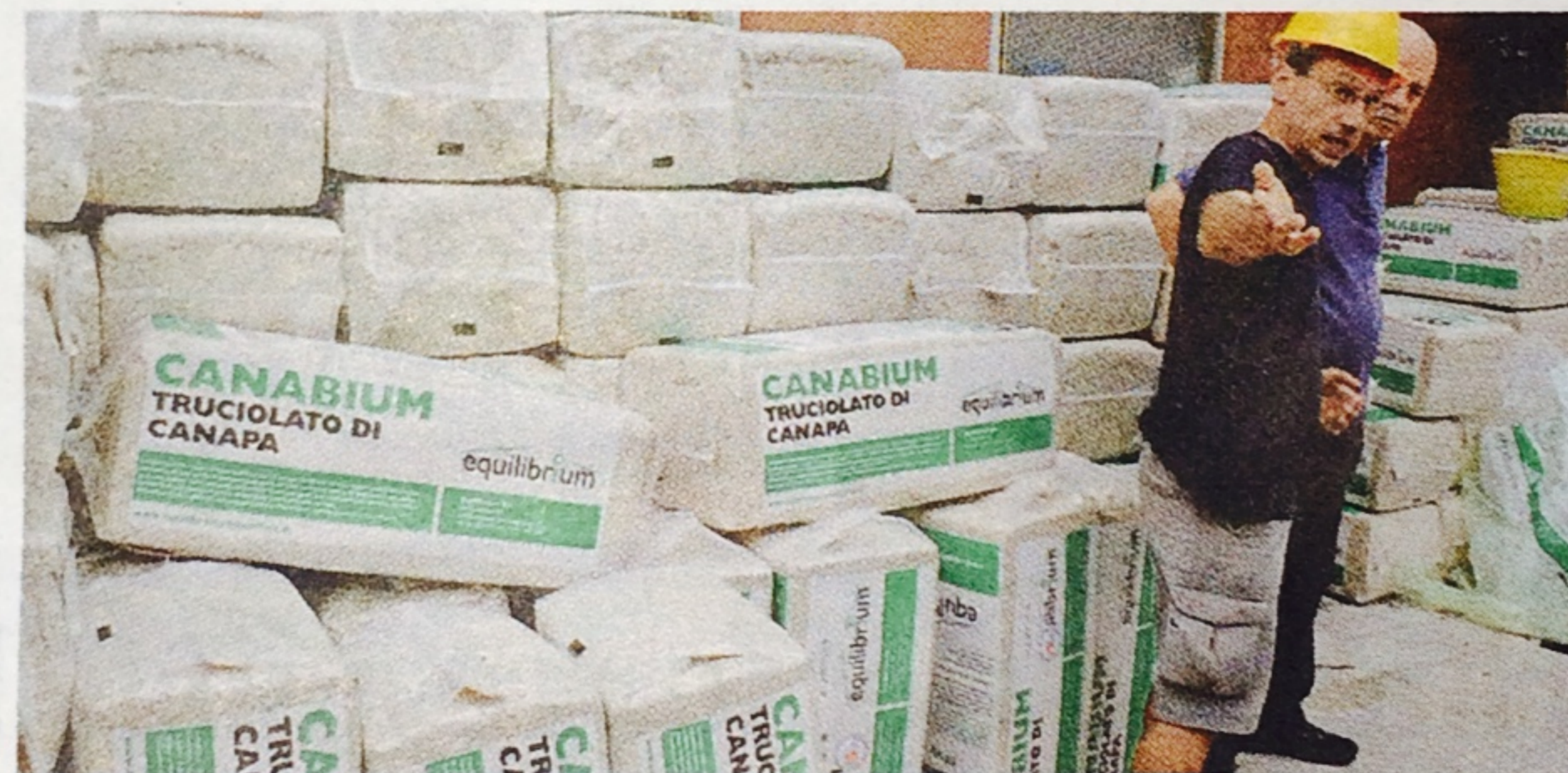
A sinistra Paola Baglini e il materiale per la costruzione stoccato all'esterno (foto Franco Silvi)
