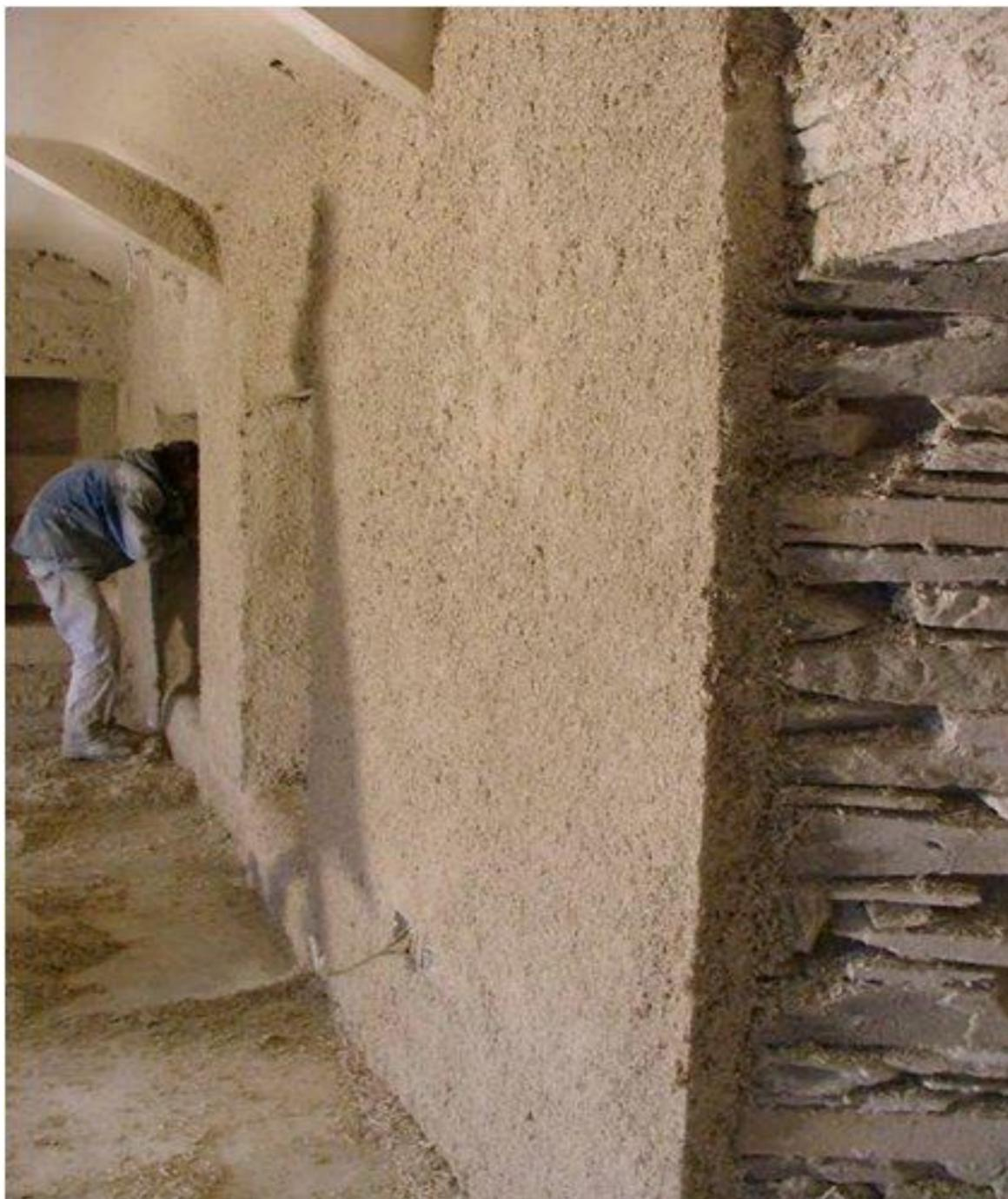
Sempre restando, in questo secondo caso sono stati posati dei blocchi in canapa e calce a un decina di centimetri di distanza dal muro esistente in pietra in modo da poter versare uno strato con sola canapa. Questa soluzione non intacca in nessun modo la muratura esistente aumentandone la capacità d'isolamento.
