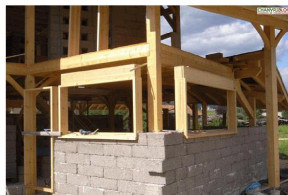
Realizzazione della ossatura in legno e successiva posa dei mattoni e serramenti preparati in stabilimento.
