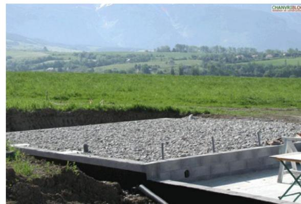
Fondazioni in cemento armato predisposte per ricevere il carico dalla ossatura in legno.
