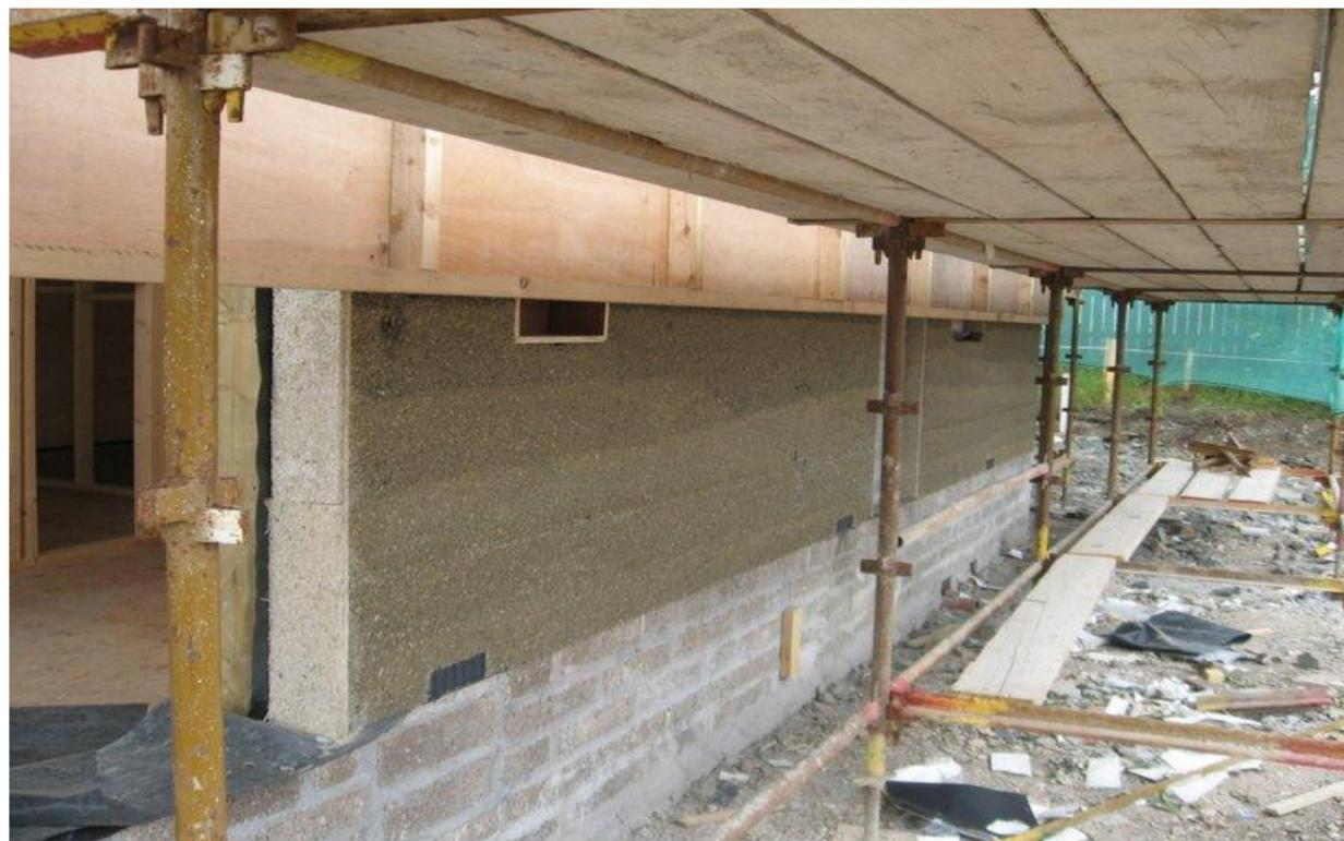
Muro realizzato "spruzzando" direttamente il biocomposito su un cassero che può essere esterno o interno in base alle necessità di cantiere, successivamente viene livellato.
