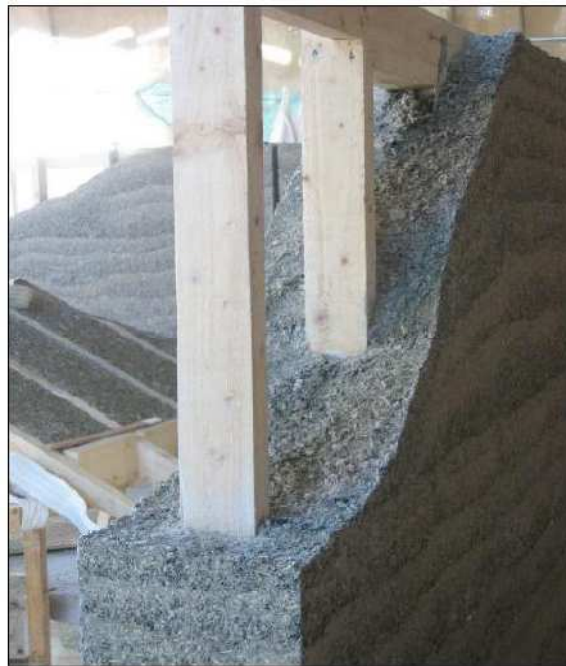
Fig. 1.7 Canapa e Calce su struttura in legno (Woolley e Bevan 2007)
