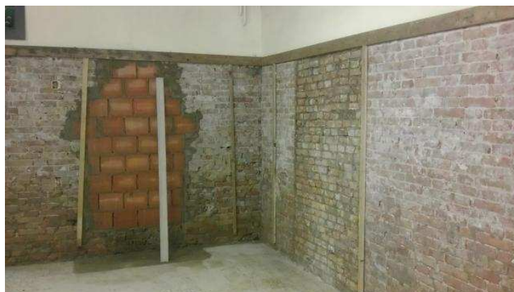
Fig. 1.11 Prima dell'applicazione Termo-Intonaco interno Isolante In Calce & Canapa Castelmassa (RO)
