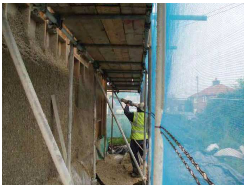
Fig. 1.9 Cemento di canapa e calce come isolante per pareti esterne
