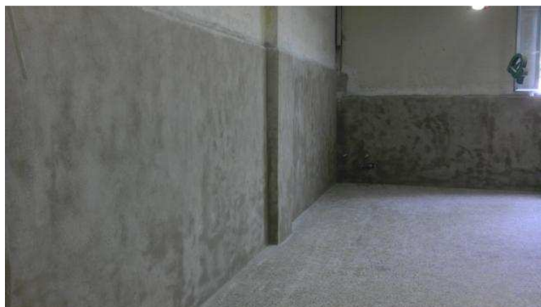
Fig. 1.12 Risultato dopo applicazione Termo-Intonaco interno Isolante In Calce & Canapa Castelmassa (RO)
