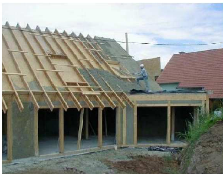
Fig. 1.8 Cemento di canapa e calce come isolante per tetti (Woolley e Bevan 2007)
