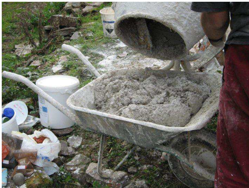
Fig. 1.6 Biocomposito canapa & calce dopo miscelazione
